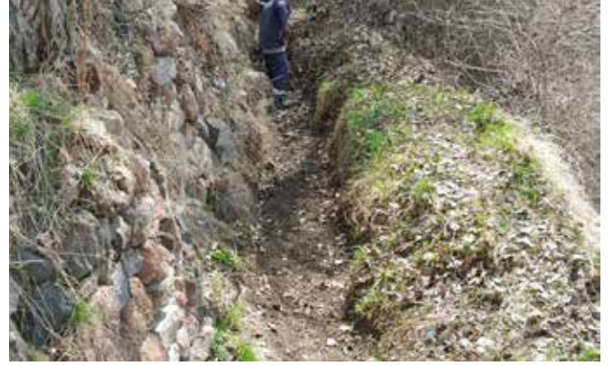
Sulama Suyu Kanalının Temizliğini Yapmak
