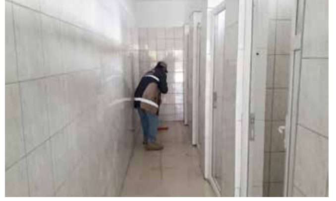
İlçemiz Sınırlarındaki Umumi Tuvaletlerin Yıkınması ve Temizlenmesi
