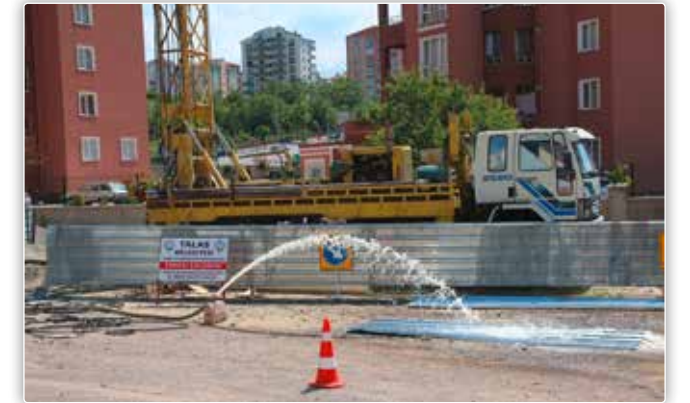
Müdürlüğümüze bağlı yeşil alanların yer altı sularından faydalanarak sulanması için sondaj çalışmaları yapılmıştır.
