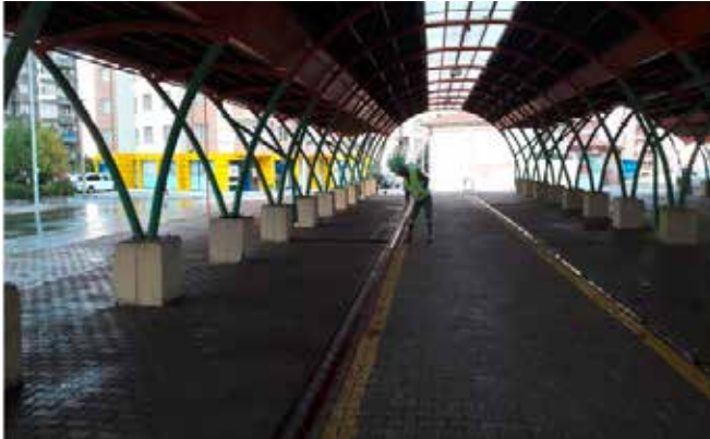
İlçemiz Sınırlarında Olan Pazar Yerlerinin Yıkılması ve Temızlenmesi
