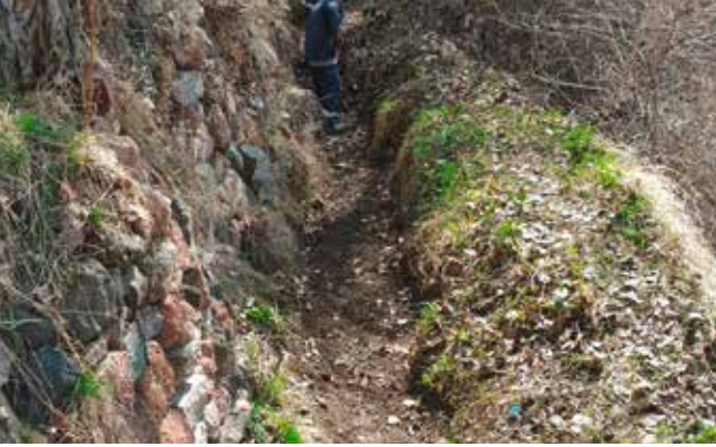
Sulama Suyu Kanalının Temizliği
